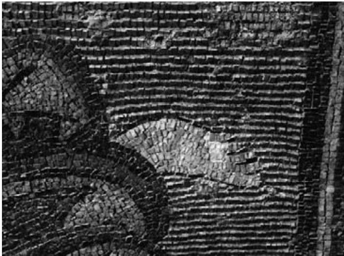
11. Le tessere a lamina metallica utilizzate nell'arco trionfale sono inserite con una inclinazione verso il basso di 45°
