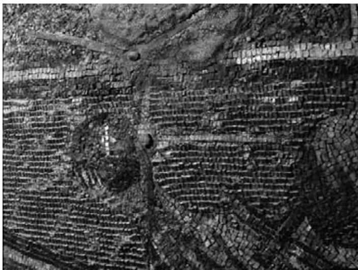
13. Le staffe metalliche collocate dal monaco Samuele nel 1847 a sostegno delle aree distaccate del mosaico sono ancora presenti sull'arco trionfale.
