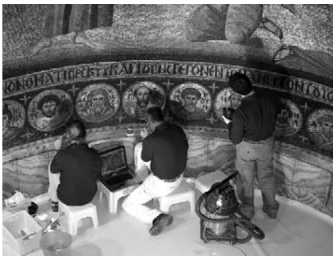
14. Veduta d'insieme dei conservatori al lavoro sul mosaico dell'abside.
